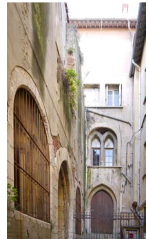
Façade nord du corps de bâtiment sud adjacent à la salle capitulaire.
