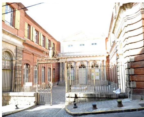
Bâtiment actuel Le manque de recul ne permet pas d'ouvrir la vue
