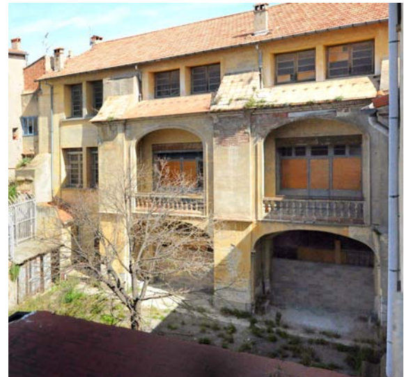
Façade sud de l'église et école. (Avant travaux de l'Université)
