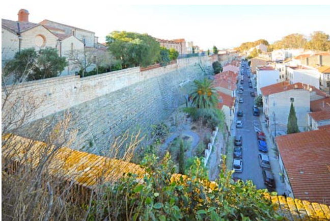
Vue générale des remparts nord-est dominant les maisons de l'îlot AS 22 situées au pied des courtines.
