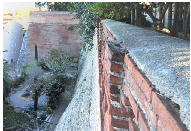
Bastion Saint-Jacques : appareillage en briques et chaînage d'angle en pierres de taille.
