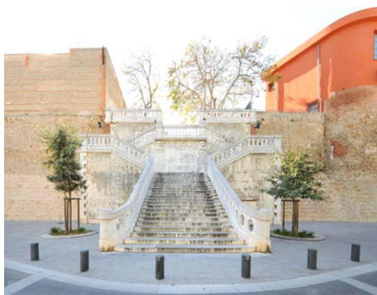
Vues générales de l'escalier Molière : depuis la place,
