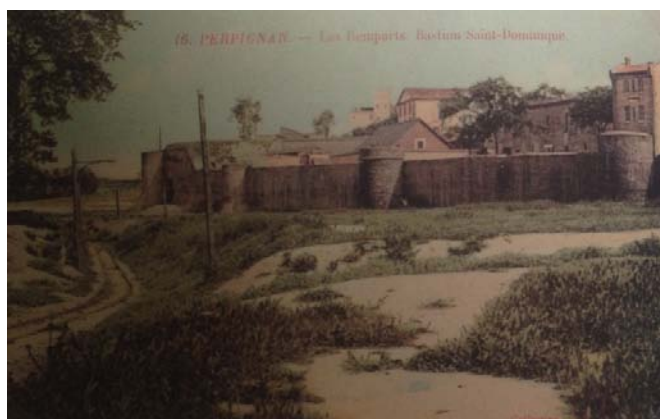
Bastion Saint-Dominique détruit, à gauche apparaît le tracé de la voie de tramway menant à Canet-Plage (Coll. Lauvernier, P.)
