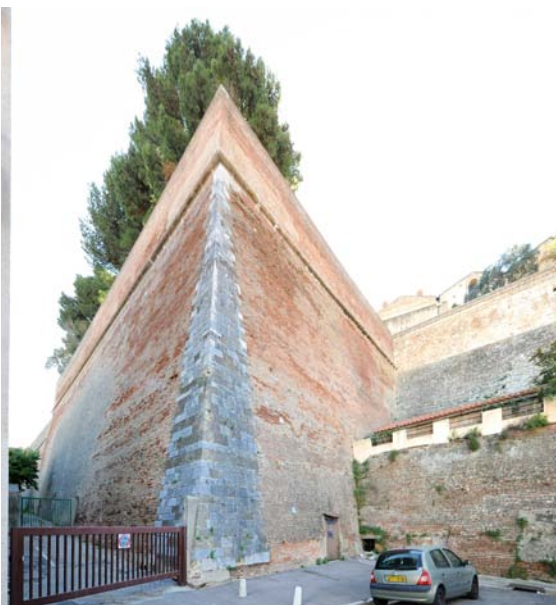
Bastion St Jacques et étagements des niveaux de remparts. AS 22-524
