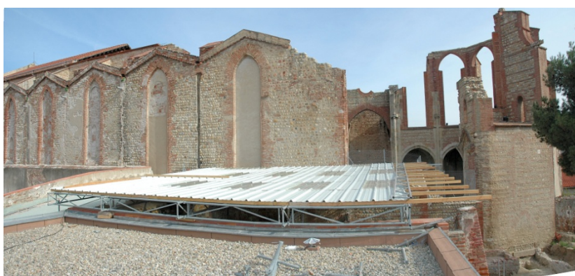
Vue générale du chevet depuis le sud-est (2005)
